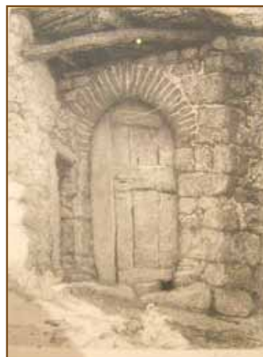
Montluçon, vieille porte, eau-forte, musée de Montluçon
