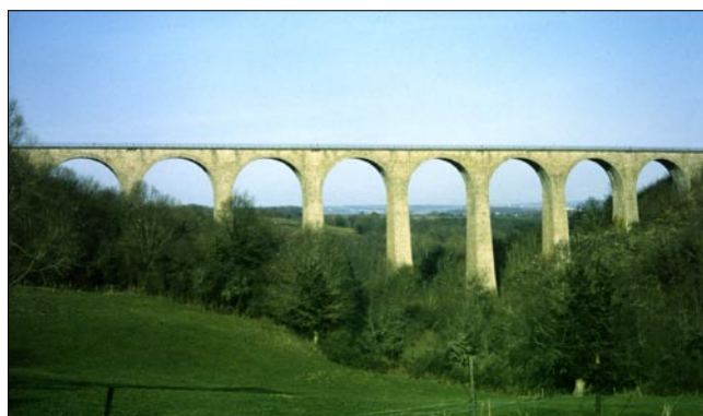
Le viaduc de Pérassier.
